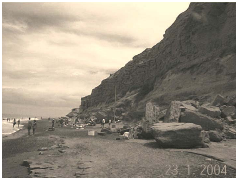
Figura 2. Zona de derrumbes del acantilado
