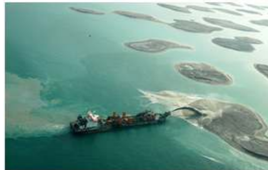
FIGURA 2. Dragado de arena del fondo marítimo.
